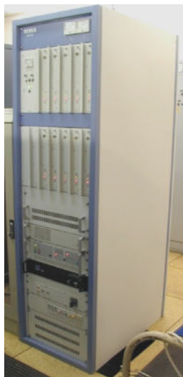
Obrázek 2: Tranzistorový vysílač 1 kW TESLA pro DVB-T
